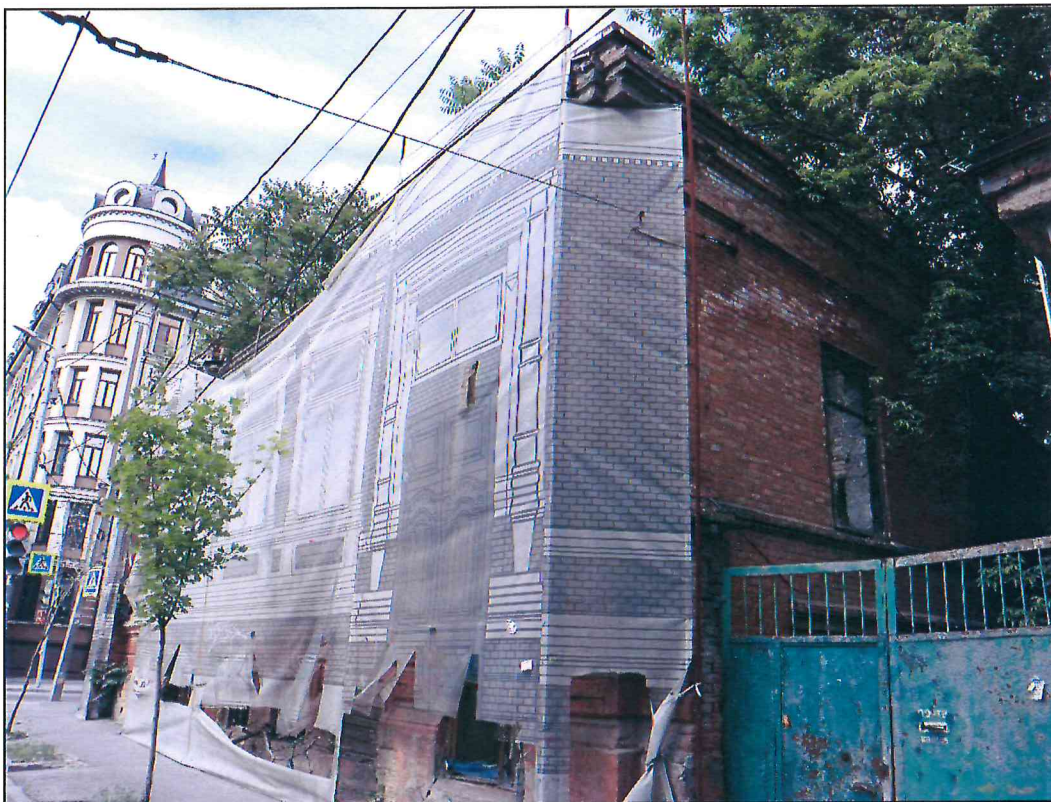
9. Вид Объекта с юго-запада Объекта. Фото 2024 г.
