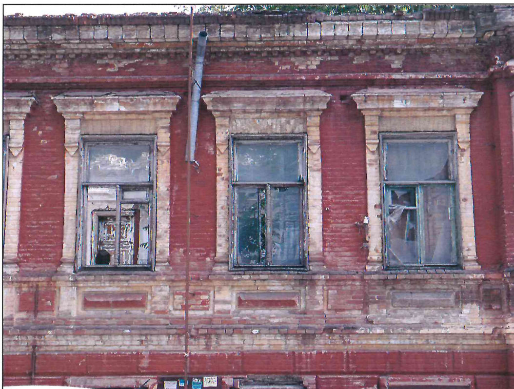
6. Фрагмент парадного северного фасада Объекта в уровне первого этажа. Фото 2024 г.
