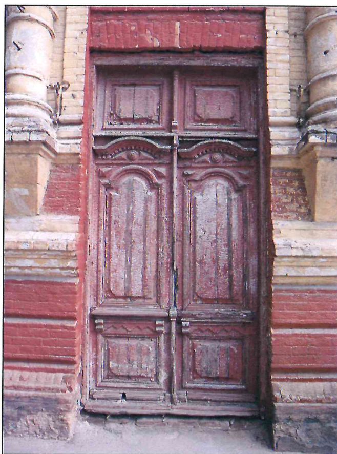
4. Фрагмент парадного северного фасада. Наружная дверь парадного входа. Фото 2024 г.
