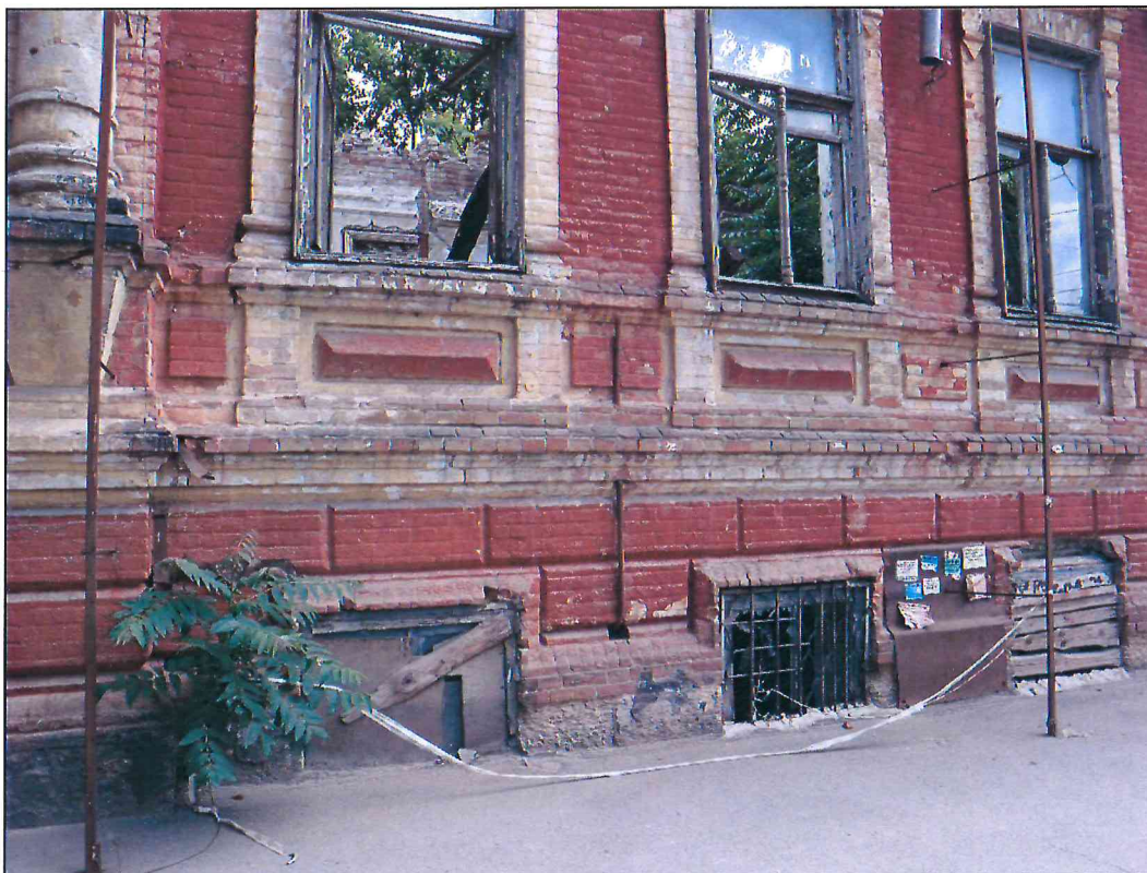
7. Фрагмент парадного северного фасада Объекта в уровне цокольного этажа. Фото 2024 г.
