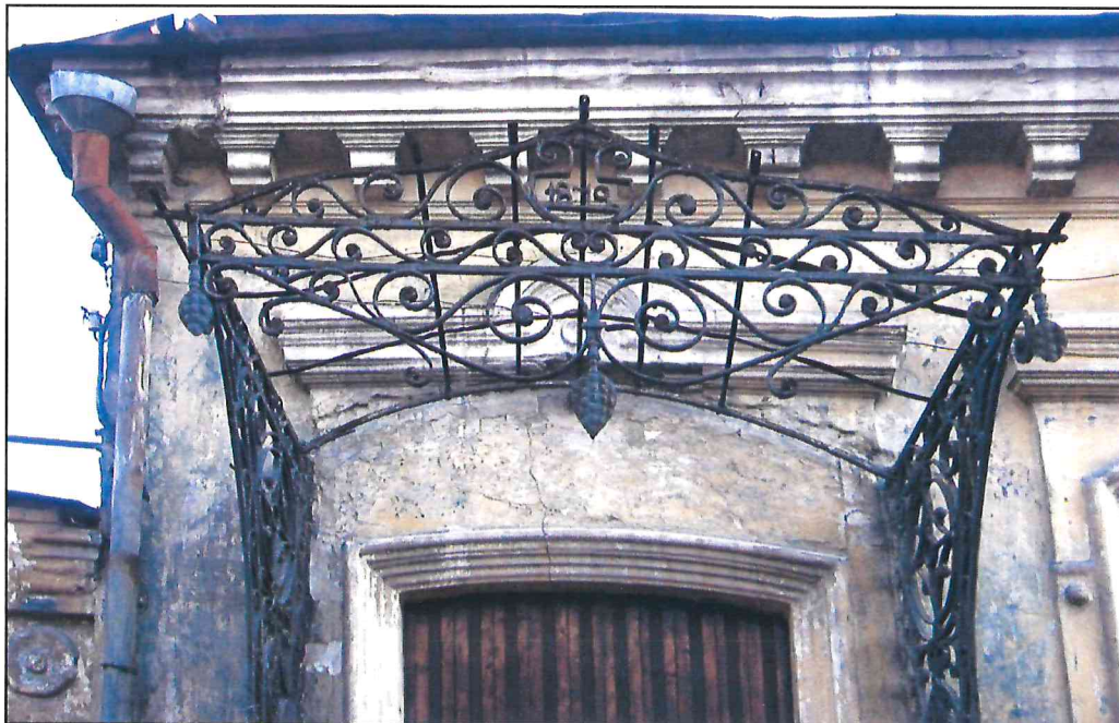
11. Фрагмент парадного южного фасада литера А Объекта. Козырек парадного входа. Фото 2010 г.
