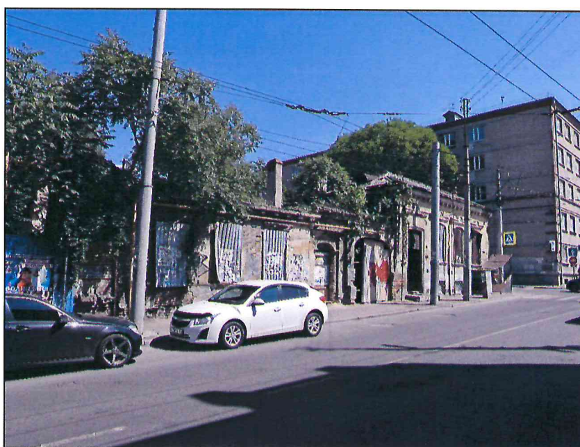
2. Вид Объекта с юго-запада. Фото 2024 г.
