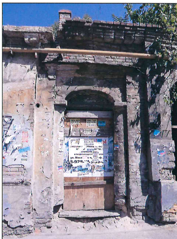
14. Фрагмент главного южного фасада литера Б, Б2 Объекта. Портал парадного входа. Фото 2024 г.
