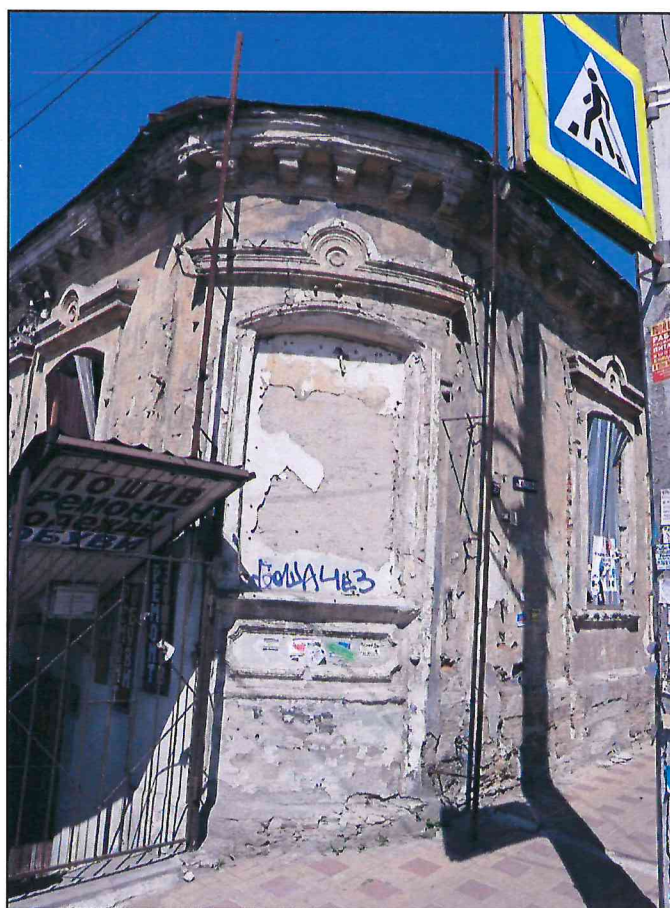
8. Угловая юго-восточная часть литера А Объекта. Фото 2024 г.
