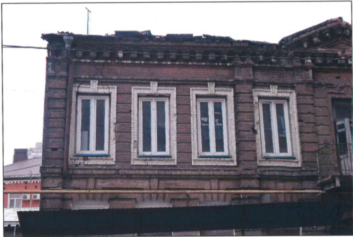
3. Фрагмент западной части главного фасада в уровне второго этажа. Фото 2023.
