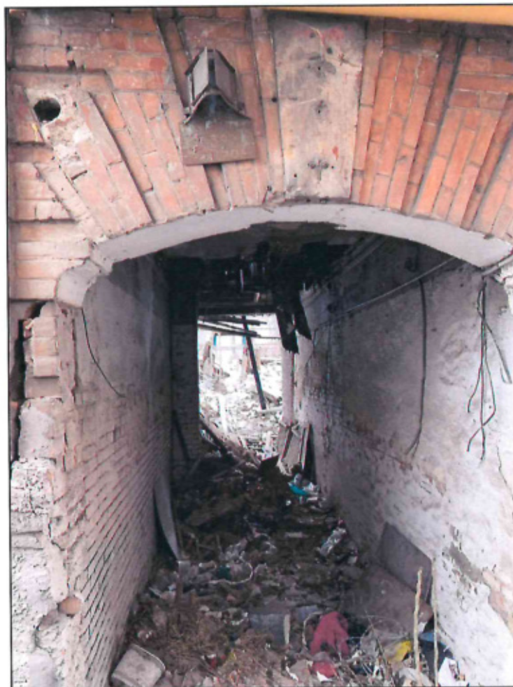
7. Фрагмент главного южного фасада Объекта. Проем внутридворового проезда.
