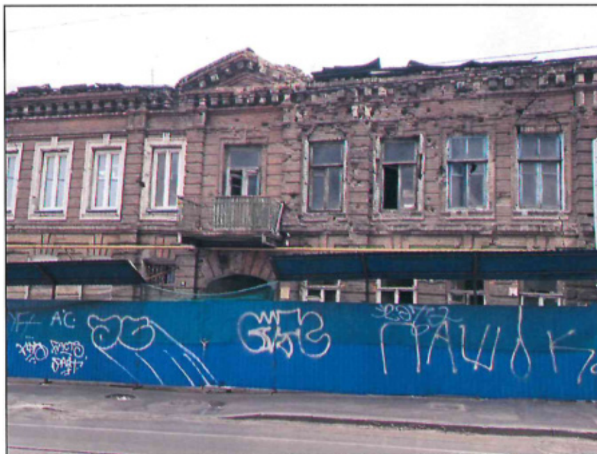
2. Главный южный фасад Объекта. Фото 2023 г.
