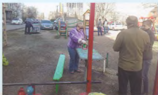
Ремонт детской площадки (ул. Магнитогорская, 9/3)
