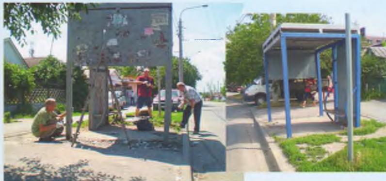
Ремонт двух остановочных комплексов (пер. Молодогвардейский)
